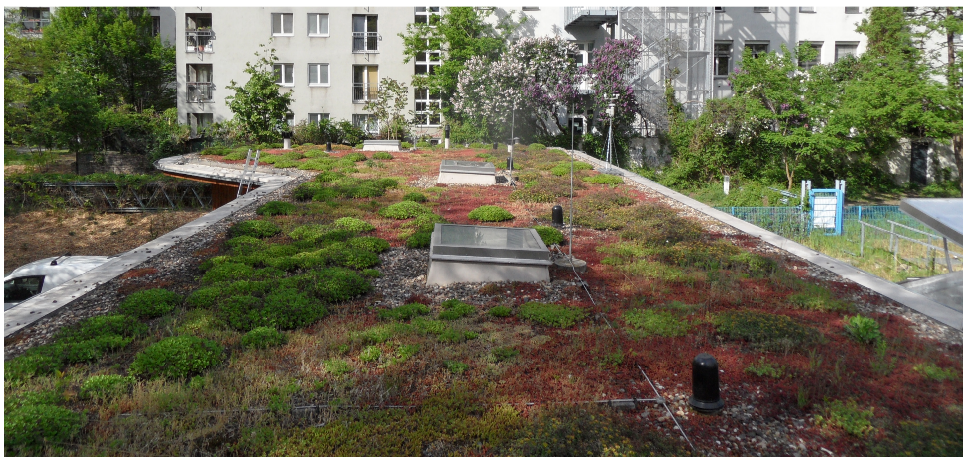
Extensive Dachbegrünung Besucherhaus
