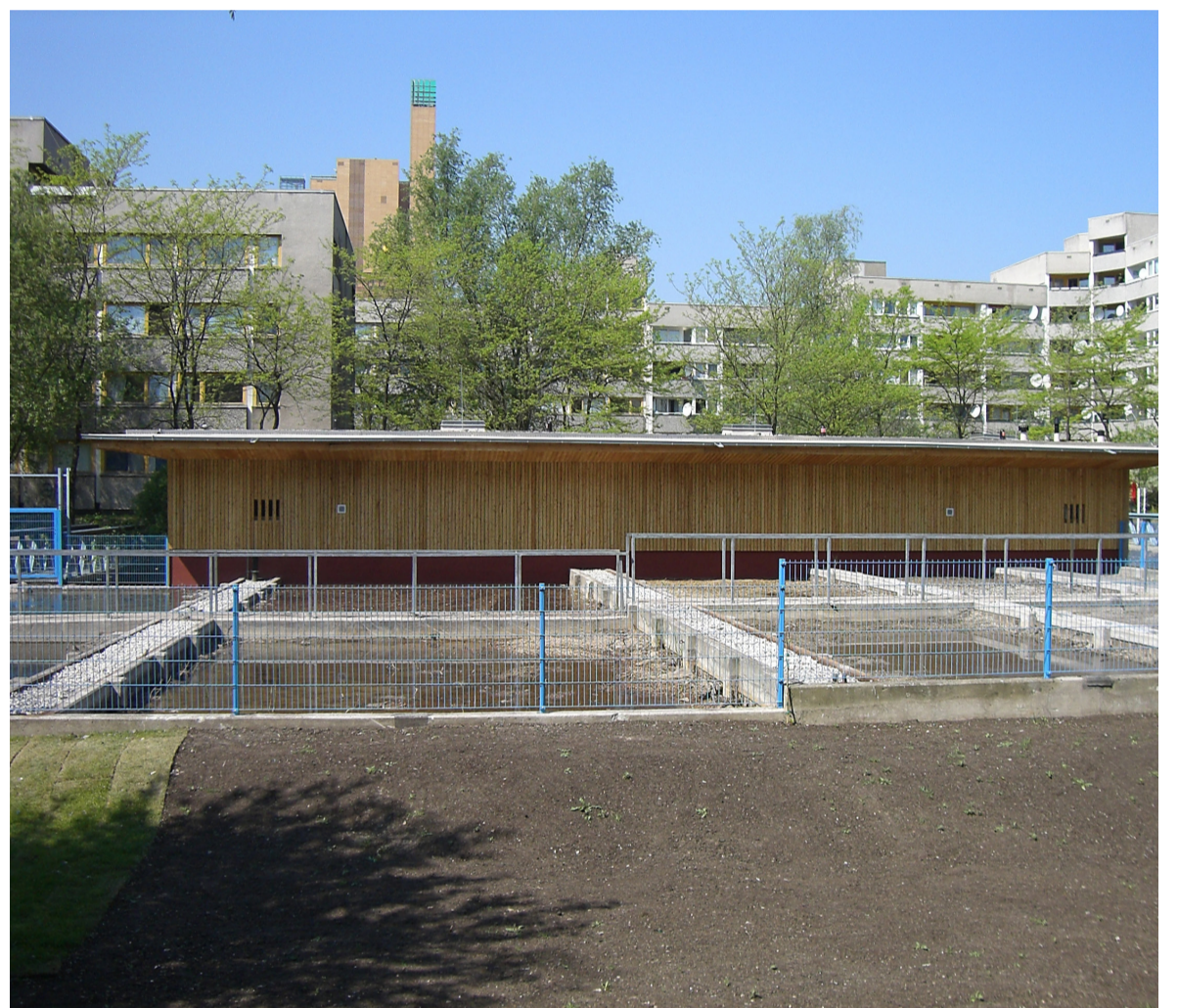
Revitalisierung der Pflanzenkläranlage
